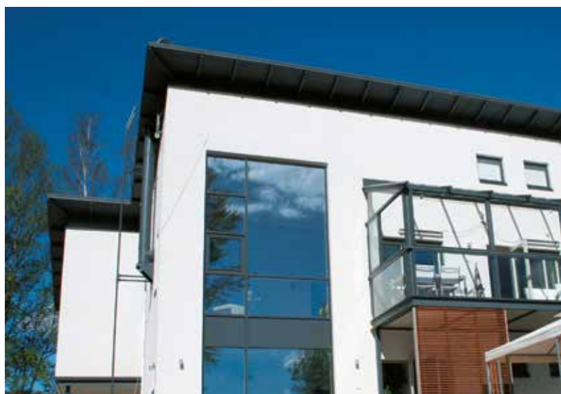
På våren ställer den starkt lysande vårsolen och den kalla nattfrosten hårda krav på reglering av inomhustemperaturen.
