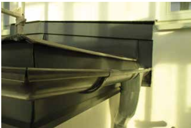
Ståndskiva med täcklist. Skyddsbeslag samt gavelbeslag vid hängränna.
