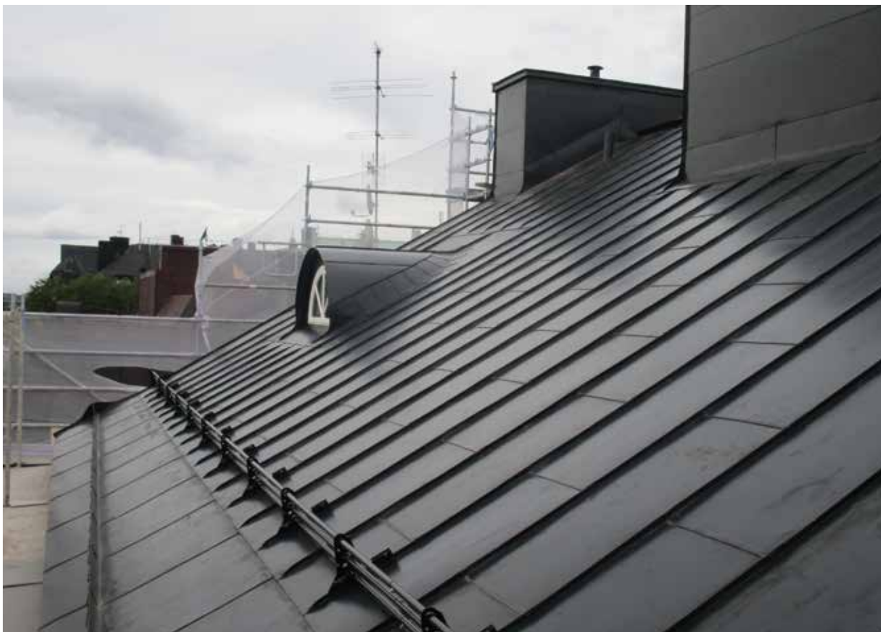
Falsat plåttak med trappad ståndskiva mot tegelfasad. Inpassade trappningsplåtar ska utföras med hake i fog och infästs med kontinuerligt fästbleck samt infästning i hake. Plåthake i fog ska efterlagas med murbruk eller mjukfogas. Skyddsbeslag ska utföras vid hängränngaveln.
