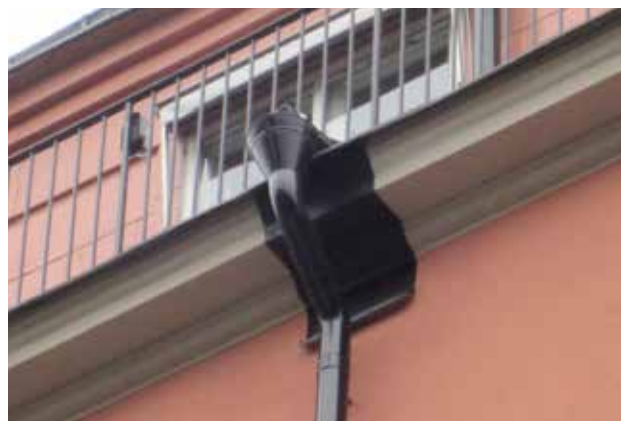
Plåttak med fotränna och skyddsbeslag bakom vattenkupa.
