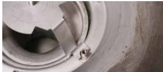
Bild H: Blücher-brunn med insatsen till Brunnskniv 206 monterad. Benen måste greppa om muttern.
