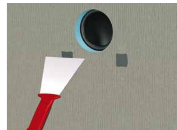
Bild T: Urtagen fylls med Maxfix eller fästmassa för ökad stabilitet.
