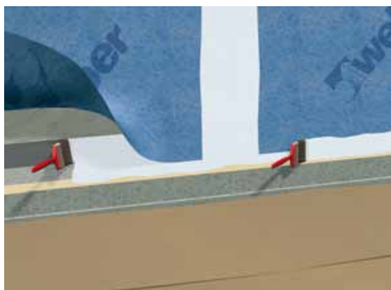
Bild B: Anslutning av Tec Folie på vägg mot plastmatta på golvet.
