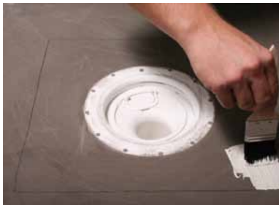
Bild I: Applicera limmet på ytan där Tec Brunnsmanschett ska placeras.
