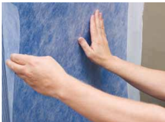
Montering av Tec Foliessystem.
