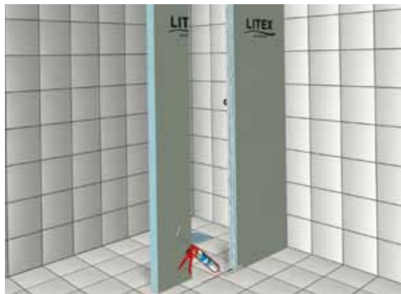
Bild Q: Skarva Litexväggen med hjälp av Litex Monteringslim och U-beslag.
