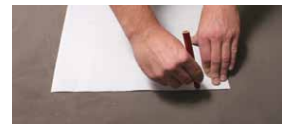
Bild E: Centrera Tec Brunnsmanschett över golvbrunnen och markera ytan med blyerts eller bläckpenna.
