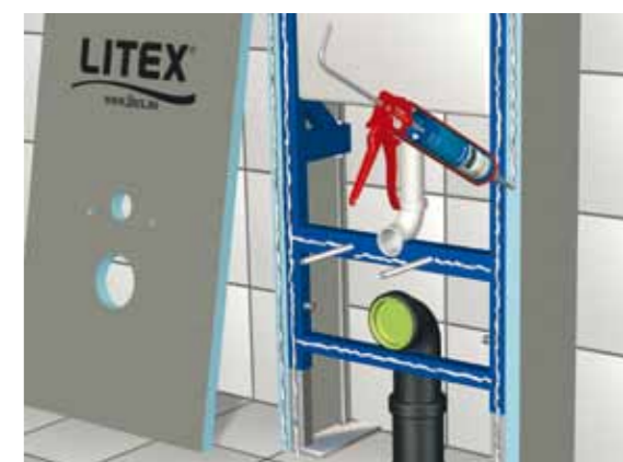
Bild R: Litex Våtrumsskiva 20 mm limmas mot keramiken, på sidorna och topp samt mot WC-stomme, med Litex Monteringslim.
