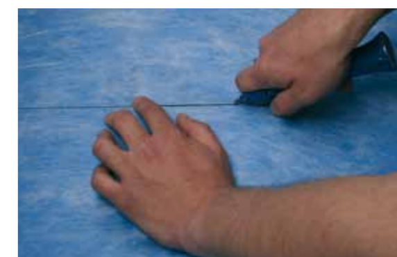
Renskar foliens kanter, avlägsna veckad och skadad folie.
