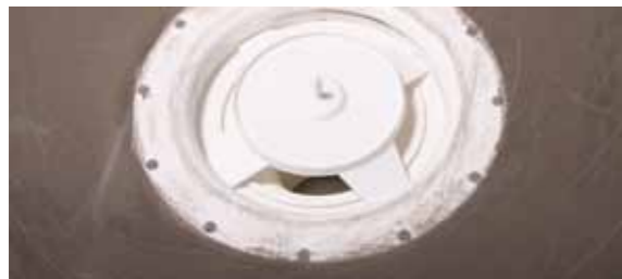
Bild F: PURUS-brunn med knivfoten monterad.
