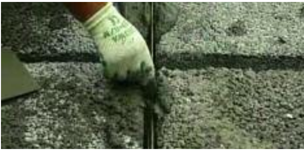
Kontinuitetsarmering läggs i. Det är viktigt att kontinuitetsarmeringen placeras centriskt i fogspåret så att den helt kringgjuts.
