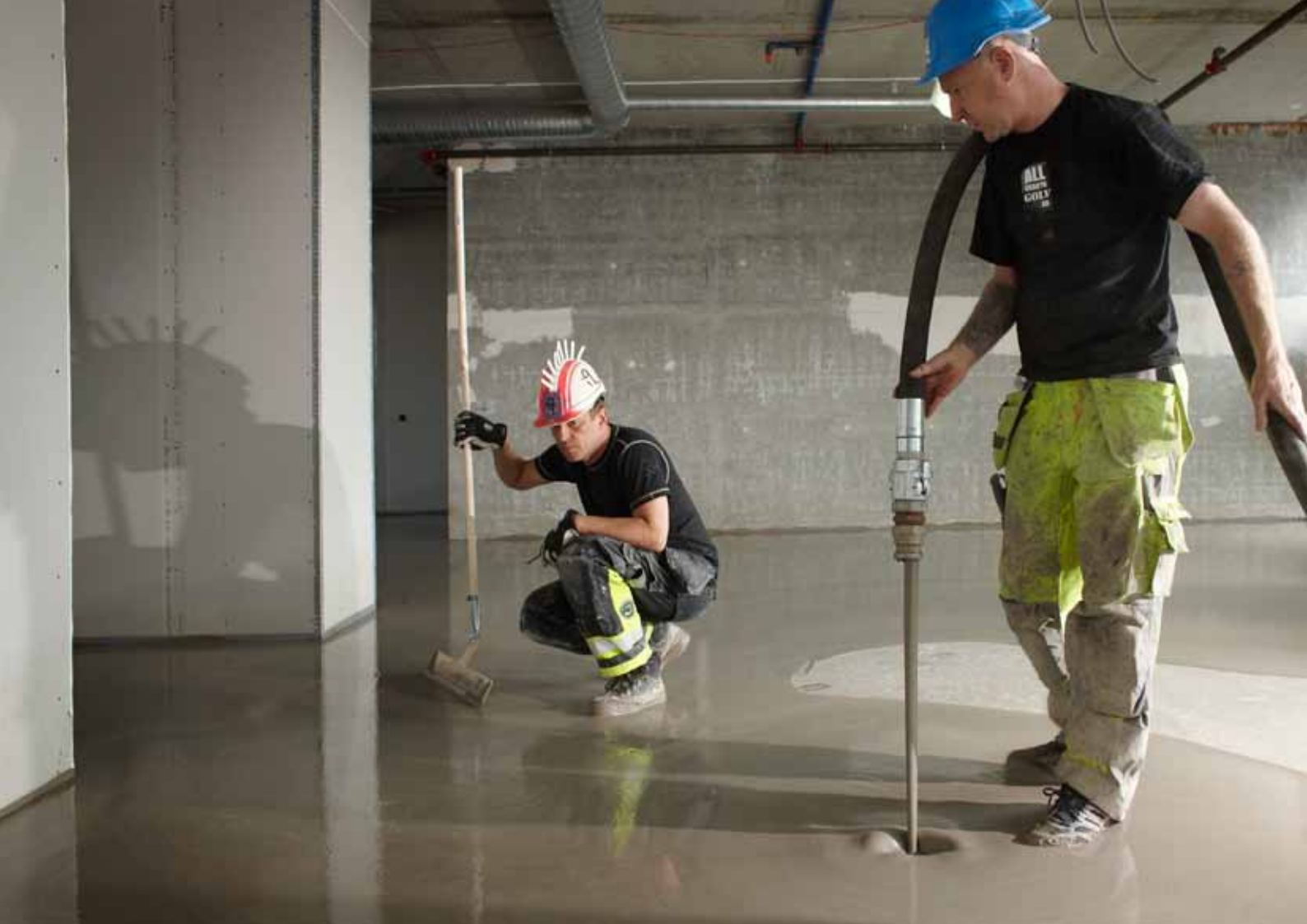
Floor 4031 Super Flow DR och Floor 4032 Super Flow Rapid DR kan läggas i tunna skikt med maskinutrustning.
