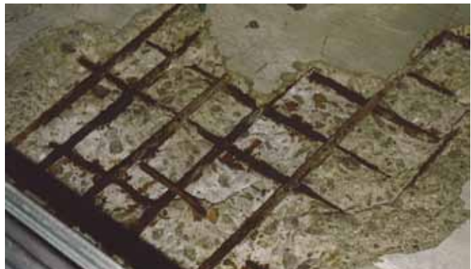
Korroderad armering
