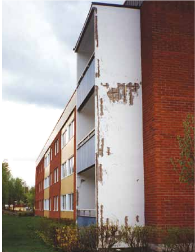
Korroderad armering
