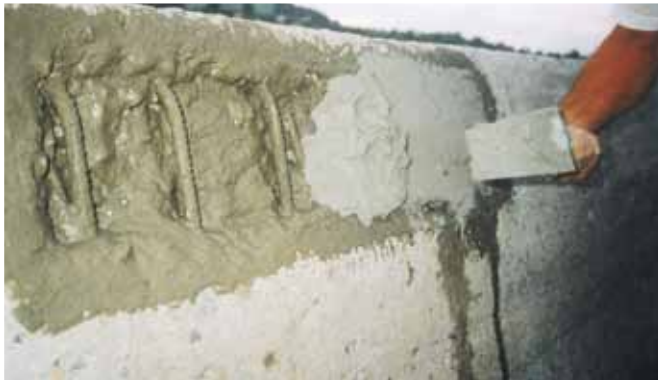
Handapplicering med fixotropt reparationsbruk som inte kräver form.
