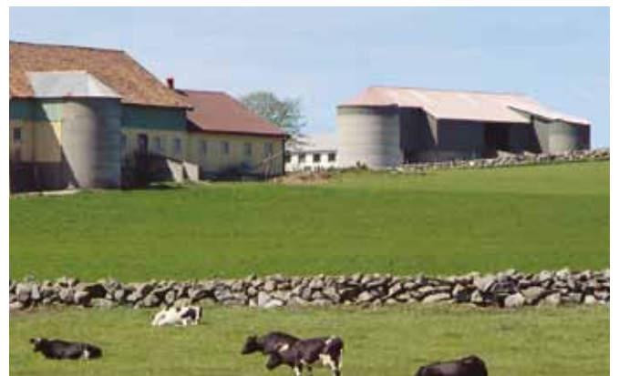
Reparerad silo för förvaring av ensilage
