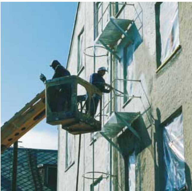
Målning och skydd av fasad
