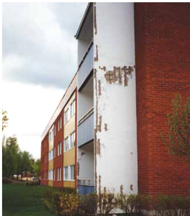
Korroderad armering
