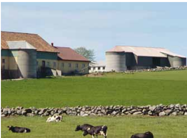
Reparerad silo för förvaring av ensilage
