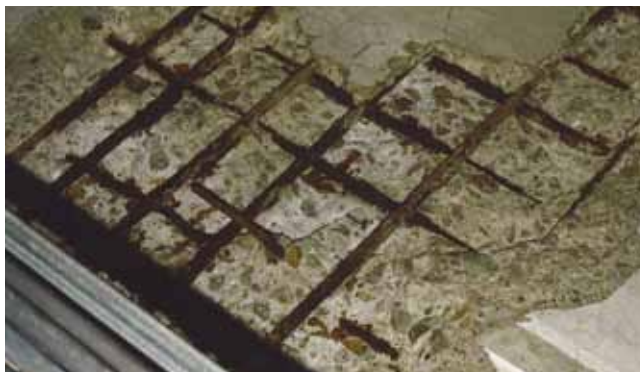
Korroderad armering
