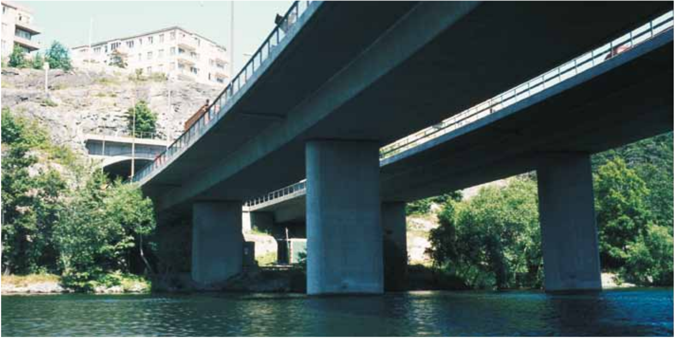
Impregnering förlänger livslängden på nya och även äldre betongkonstruktioner
