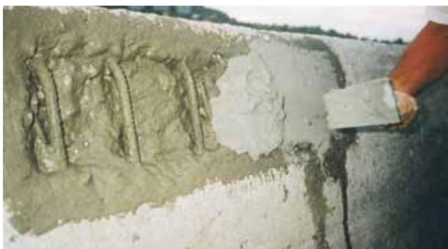
Handapplicering med fixtropt reparationsbruk som inte kräver form
